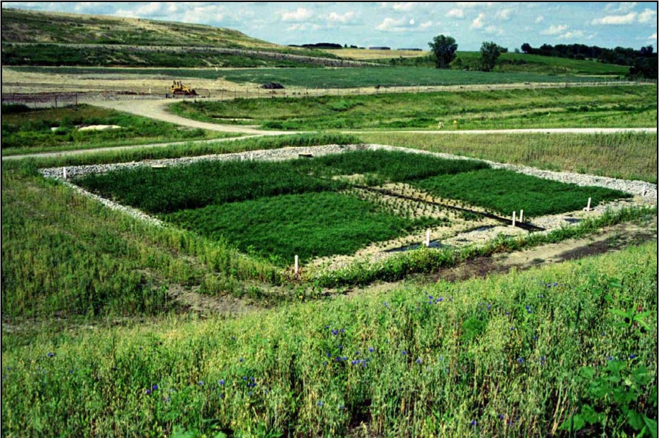
Stadio di trattamento (sistemi VF) di un complesso impianto di trattamento del percolato con fitodepurazione negli Stati Uniti
