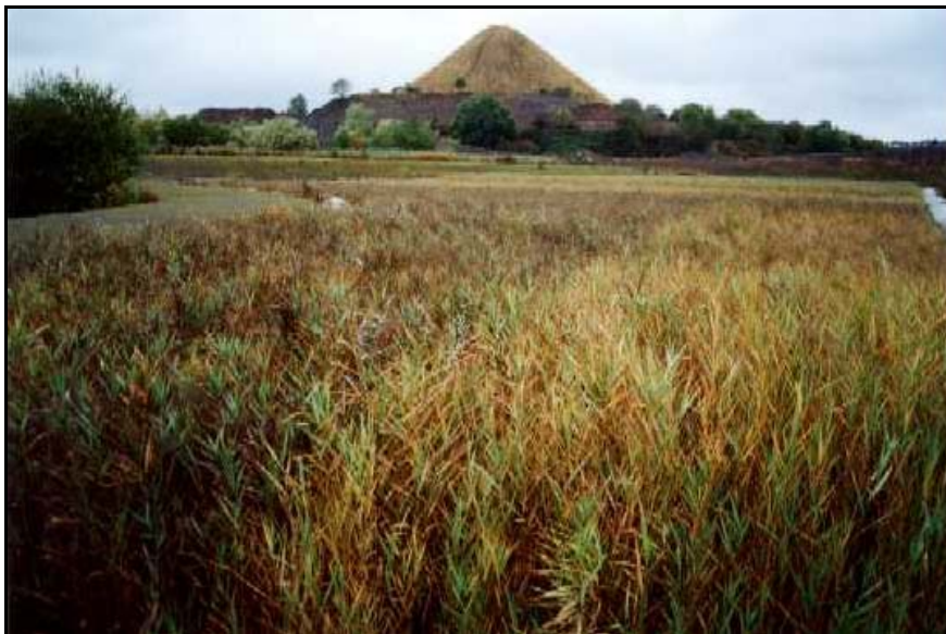
Reed bed (sistema a flusso sommerso orizzontale con fragmiteto) per il trattamento del percolato in UK
