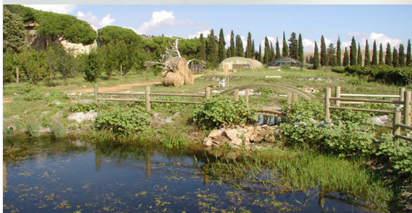
Sistema di fitodepurazione a flusso libero per il trattamento delle acque meteoriche di raccolta dei tetti e dei parcheggi del Centro Ecologico Ambientale di Rispescia (CEA)
