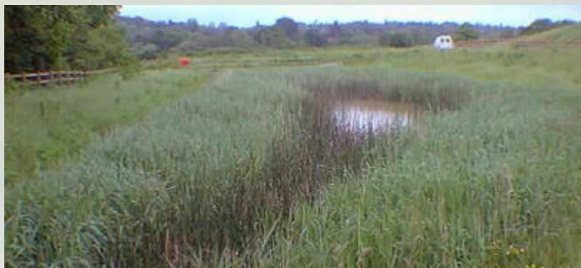
Sistema di depurazione naturale a flusso libero per il trattamento delle acque di dilavamento di un centro commerciale
