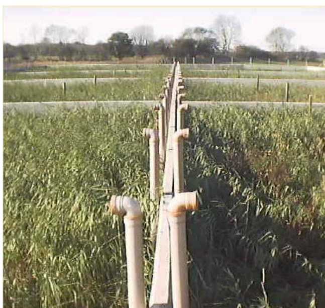
Impianto di fitodisidratazione di Kambas – Danimarca – Fonte: Envicare Ltd
