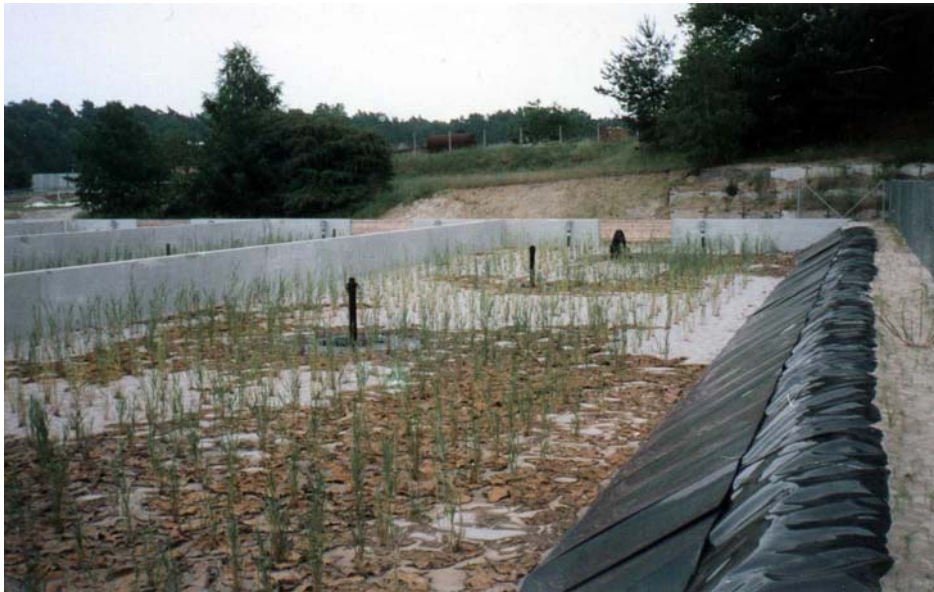
Impianto di fitodisidratazione di Lobetal – Germania - Fonte: AKUT GmbH
