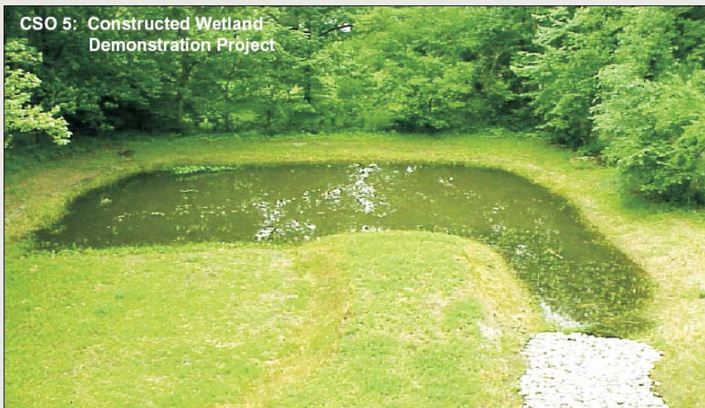
Sistema di depurazione naturale a flusso libero per il trattamento di uno sfioratore fognario di Elkart Indiana.
