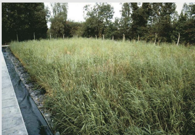
Sistema di depurazione naturale a flusso subsuperficiale orizzontale per il trattamento dello sfioro di Lighthorne Heath.
