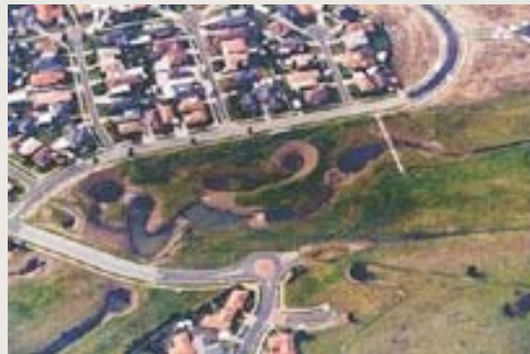
Sistema di depurazione naturale a flusso libero per il trattamento di uno sfioratore fognario di Hallam, Melbourne, Australia.
